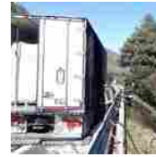
ROMA Roma, il ponte sul torrente crolla al passaggio di un autocarro: ferito il conducente
